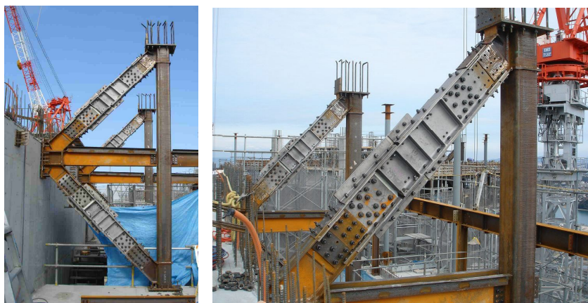
図 14 ダンパーの取付状況
