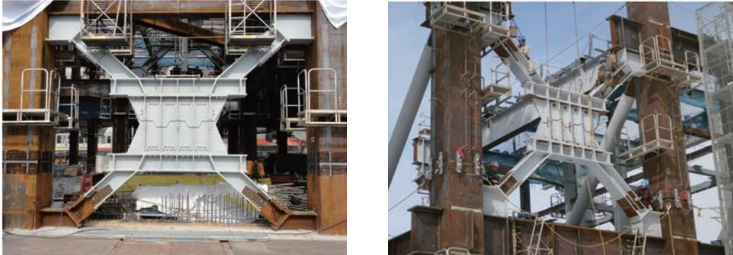
図20 FMS合金制振ダンパーの取付け状況
