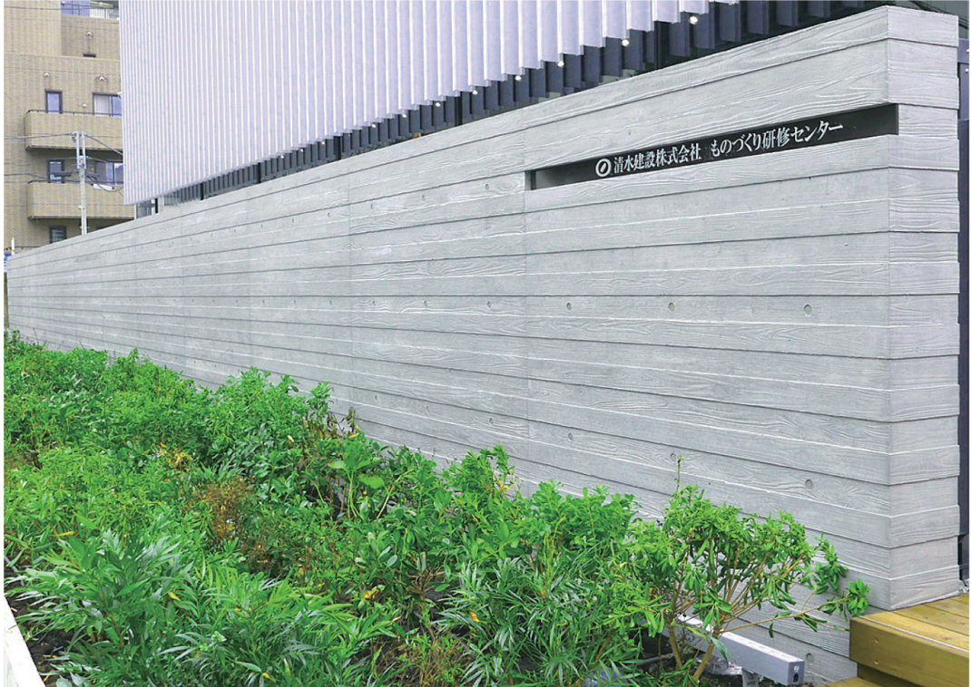
写真13 アートコンクリートの実構造物への適用状況
